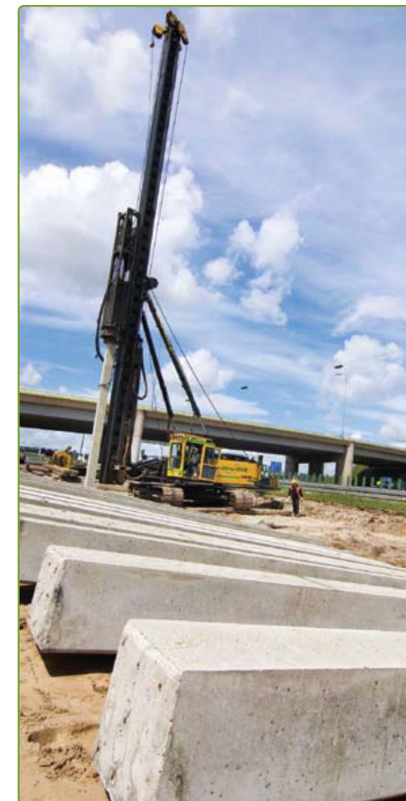
Piling ModieSlab Oudenrijn
